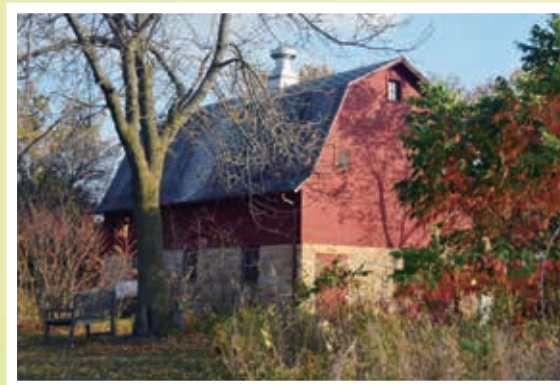
善き勤めの聖母の丘修道院に在る赤壁の納屋 (ミネソタ州マンケート)
